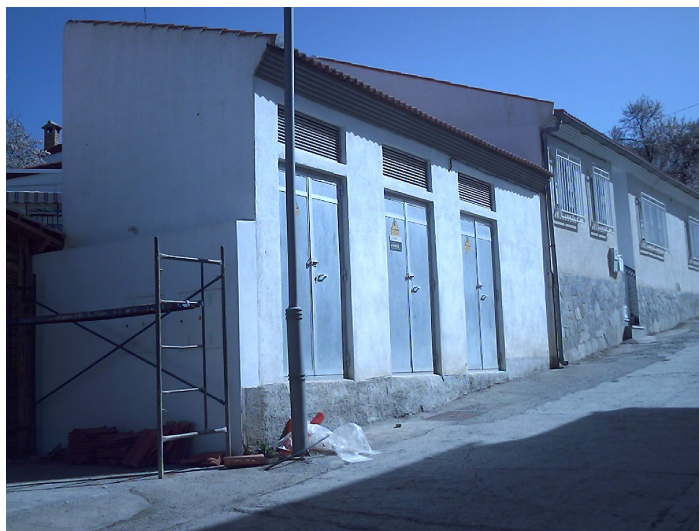
Suelo del Centro de Transformación Eléctrica
